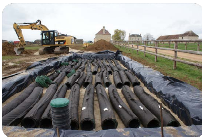
Chantier réalisé pour 25 Eh
