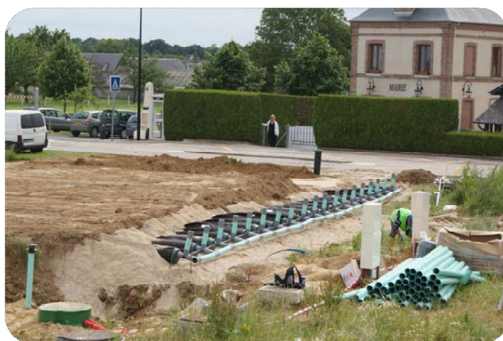
Chantier réalisé pour 57 Eh
